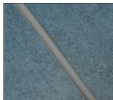
11.1.12 De petites irrégularités ou réparations peuvent être réalisées avec un outil de lissage chauffant.
